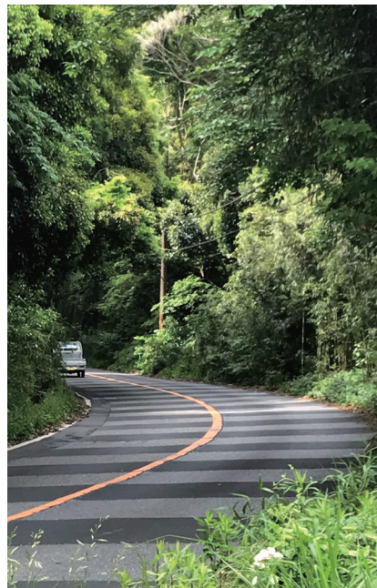
木の枝が道路に覆いかかる国道410号線
