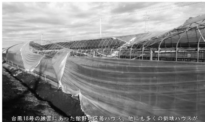
台風18号の被害にあった館野地区苺ハウス、他にも多くの倒壊ハウスが
