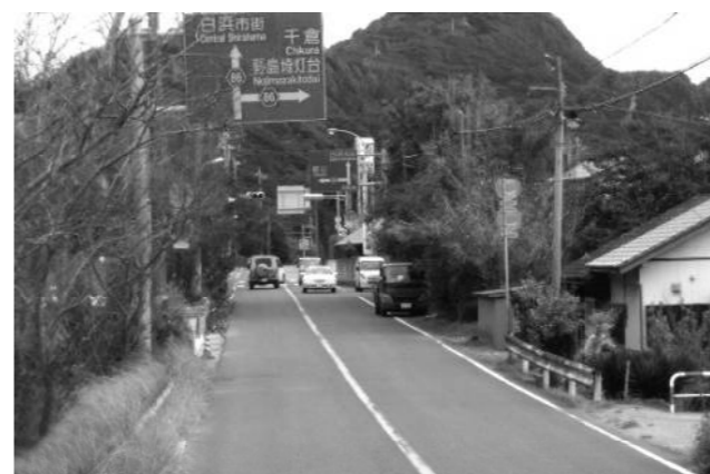
歩道のない幹線道路は住民にとっては危険がいっぱい。
